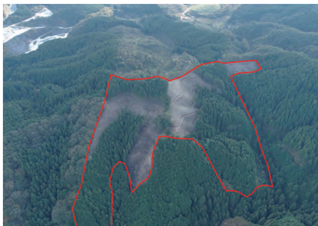
第90号イチゴ谷契約地での施業の状況
