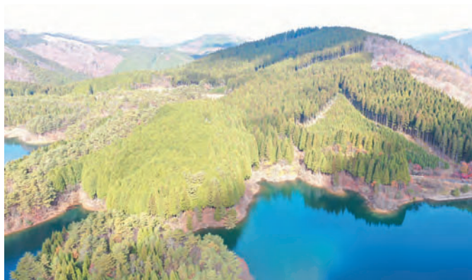
寺前契約地をドローンにより上空から撮影 手前はダム湖
