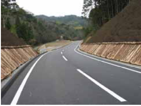
丸太法面伏工の施工状況 金城・三隅線 三隅区間（島根県）
