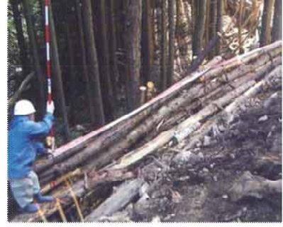
簡易丸太柵工の施工状況 広見・篠山線 小岩道・鳥越 (愛媛県)
