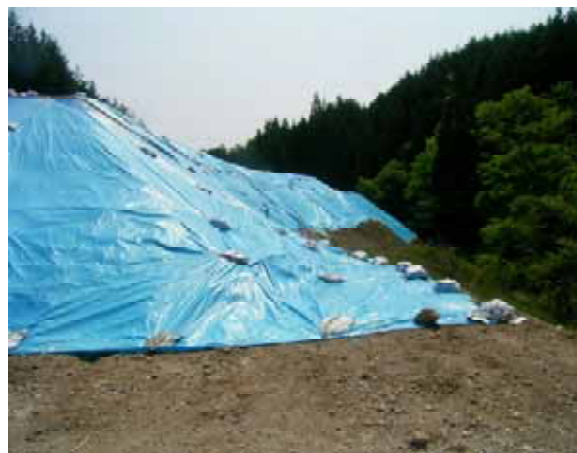
土砂流出防止のためのシート設置状況
