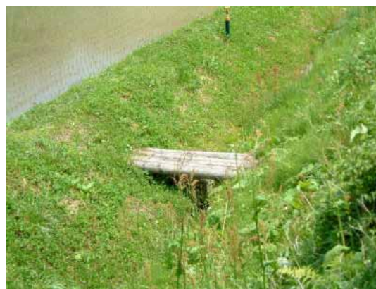
水路への渡り橋の設置 (郡山区域：福島県)
