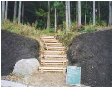
木製階段工の施工状況 関ヶ原・八幡線 春日・久瀬区間（岐阜県）
