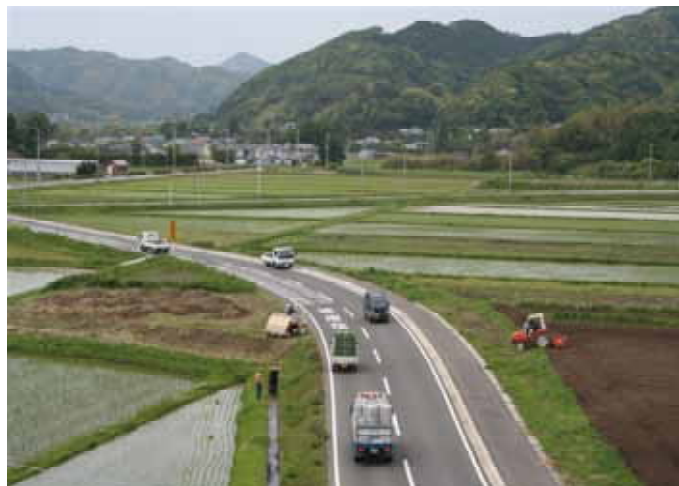
供用を開始した農業用道路の利用状況 （安房南部区域：千葉県）
