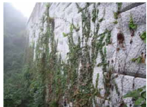
ツタによる壁面緑化の状況 (直入庄内区域：大分県)
