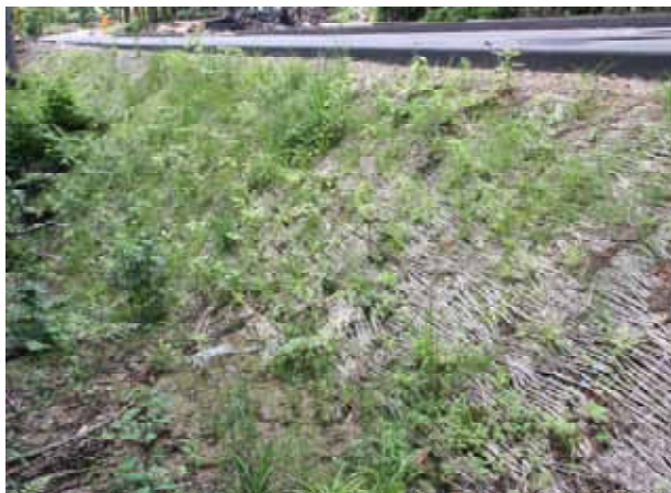
盛土法面の施工状況
