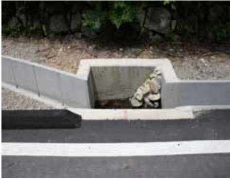
スロープ付き集水柵の施工状況 大朝・鹿野線 戸河内・吉和区間（広島県）
