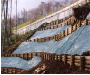
丸太柵工の施工状況 葛巻・田子線 浄法寺・田子区間 (岩手県)
