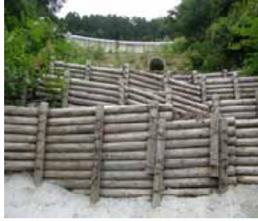
丸太柵工の施工状況 宇目・小国線 宇目区間 (大分県)
