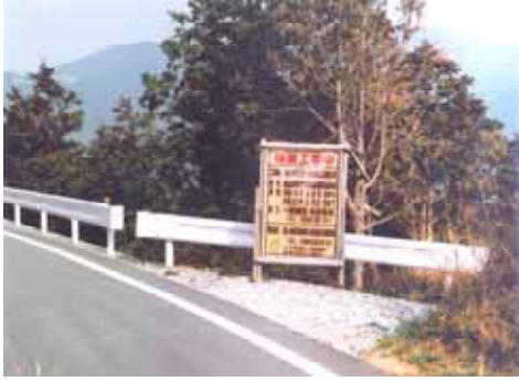
木製工事看板の設置状況
