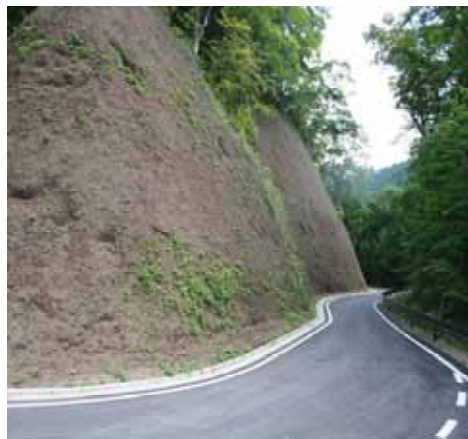
切土法面の施工状況
