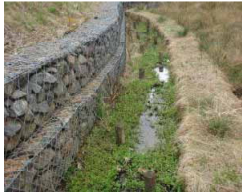
環境配慮型水路の自然再生状況 (南丹区域：京都府)
