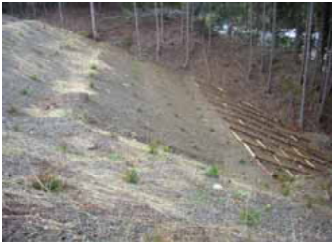
丸太法枠工の施工状況 関ヶ原・八幡線 久瀬・根尾区間（岐阜県）
