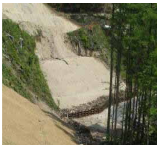
土砂流出防止柵の設置状況 (下閉伊北区域：岩手県)
