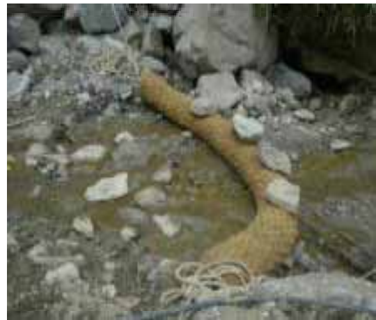
マットを利用した土砂流出防止対策
