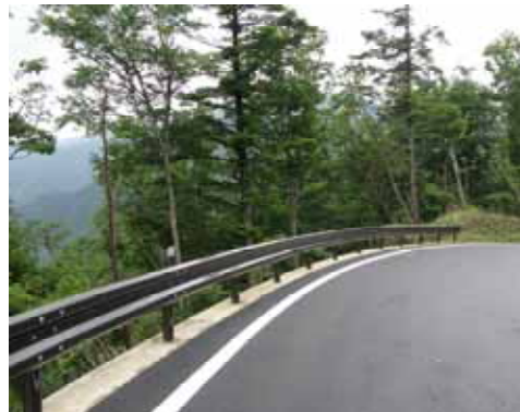
ガードレール工の施工状況
