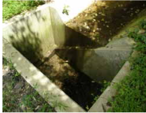
スロープ付き集水柵の施工状況 宇目・須木線 西米良・須木区間（宮崎県）
