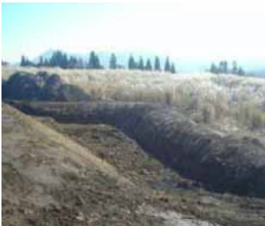
沈砂池の設置状況
