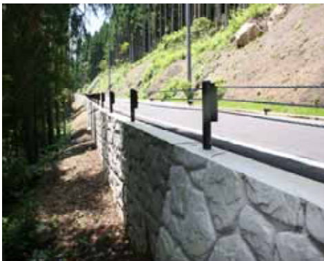
疑岩擁壁とガードケーブル工の施工状況
