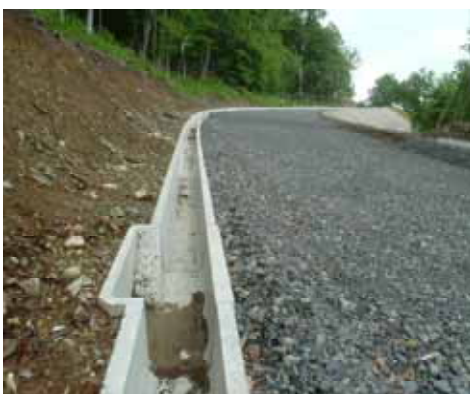
スロープ付き側溝の施工状況 川井・住田線 横沢・荒川区間(岩手県)
