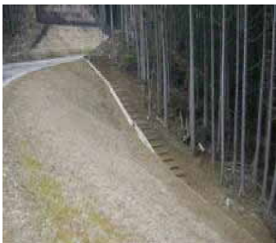
木製階段の設置状況 (美濃東部区域：岐阜県)
