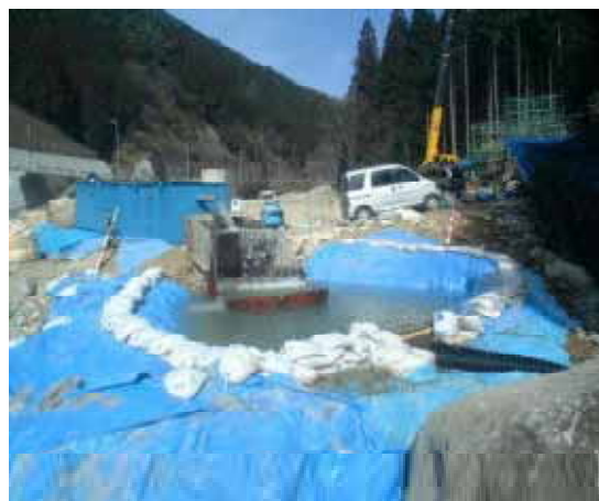
沈砂池の設置状況 (美濃東部区域：岐阜県)
