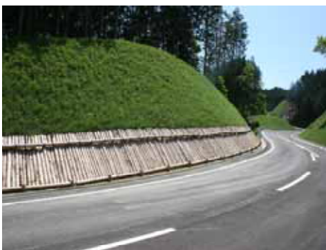
丸太法面伏せ工の施工状況 高尾・小坂線 西城・東城区間（広島県）
