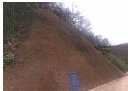
法面保護工の仕上がり状況 (南丹区域：京都府)
