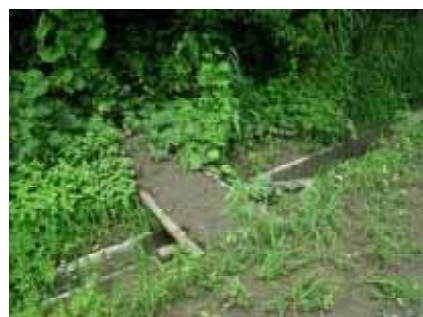
丸木橋の設置 (郡山区域：福島県)
