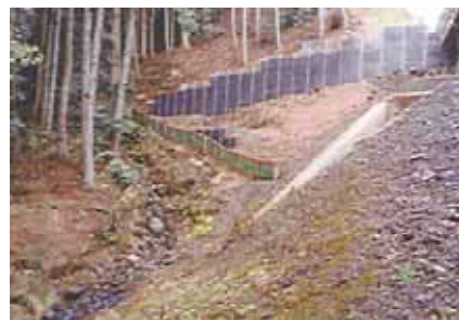
土砂流出防止柵の設置 (南丹区域：京都府)
