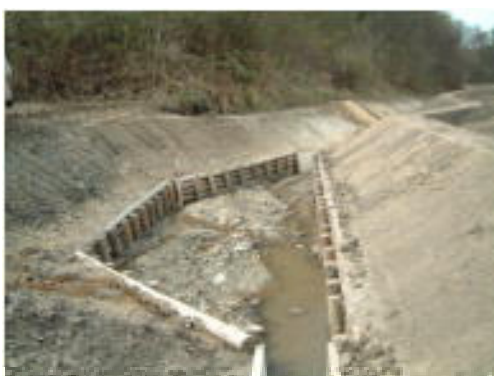
木製水路工 (郡山区域：福島県)
