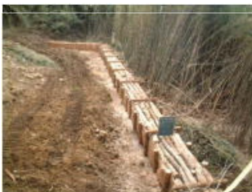
土砂流失防止柵工 (安房南部区域：千葉県)
