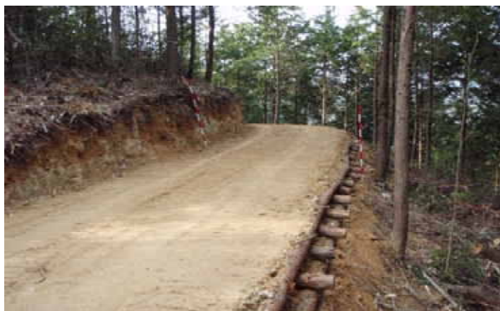
(丸太組工法による作業道)
