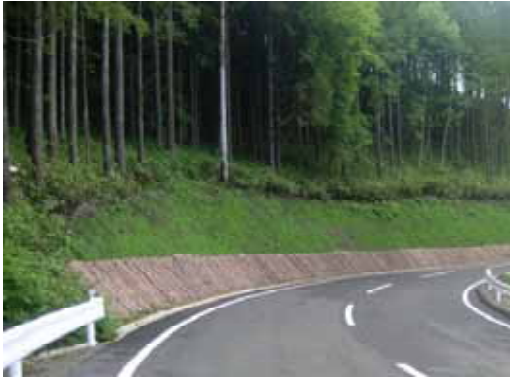
(八幡・高山線 馬瀬・萩原区間) 法面緑化工事、舗装工事等の仕上げ工 を実施し、地元市町村に移管します。
