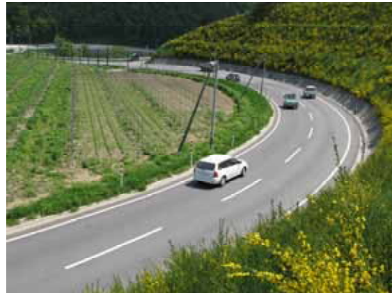
供用中の農業用道路
