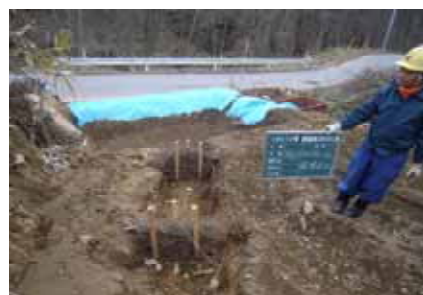
沈砂池の設置 (下閉伊北区域：岩手県)
