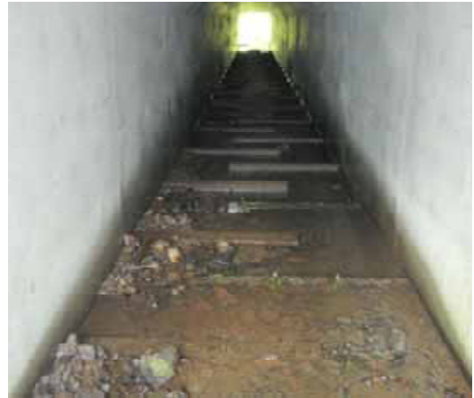
道路横断工の隔壁の効果 (南丹区域：京都府)
