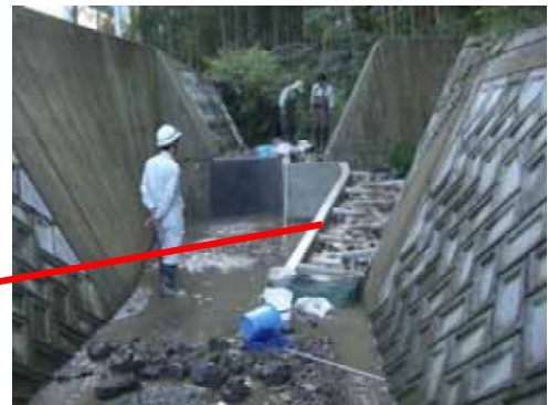
魚道の検証状況
