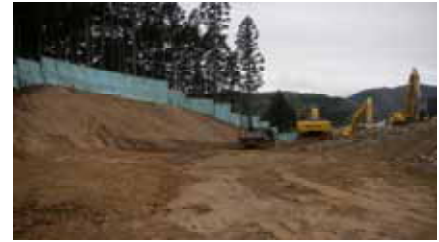
防音シートの設置 ( 邑智西部区域：島根県 )
