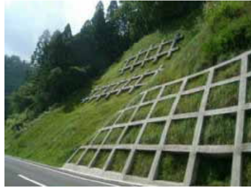
(清水・東津野線 清水・三原区間) 被災した法面に災害復旧工事を実施 し、地元市町村に移管します。
