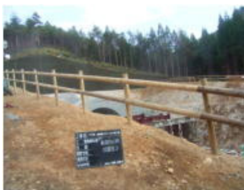
転落防止柵工 (下閉伊北区域：岩手県)
