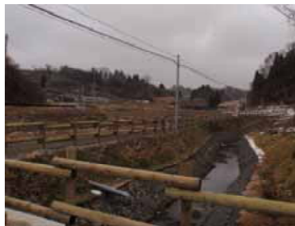
転落防止柵工
