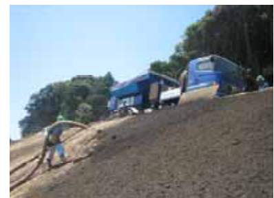
法面保護工の施工状況 （安房南部区域：千葉県）
