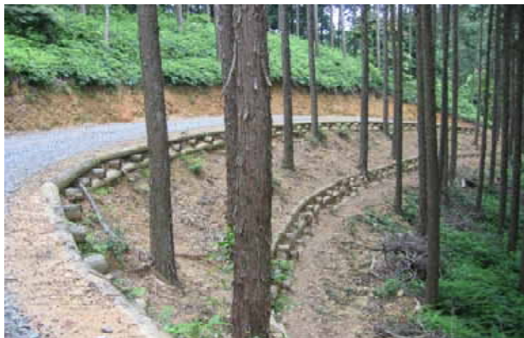
(丸太組工法による作業道)
