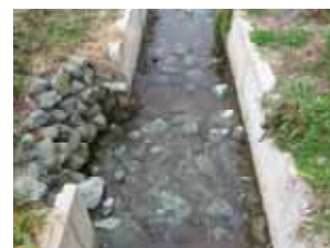
産卵場所の設置(上) 水路の改善(下) (安房南部区域：千葉県)
