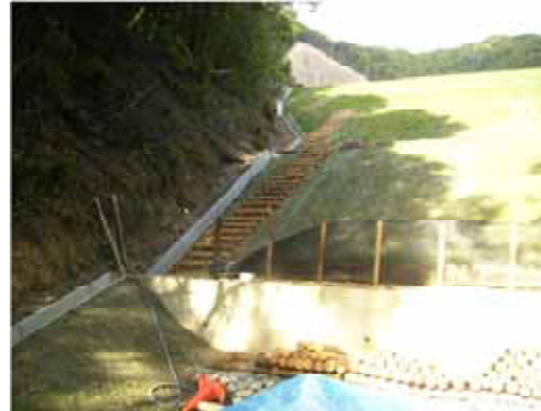
階段工 (黒潮フルーツライン区域：和歌山県)
