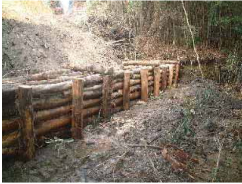
土砂流失防止柵工 (安房南部区域：千葉県)
