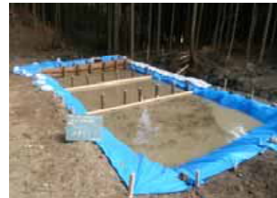
沈砂池の設置 （美濃東部区域：岐阜県）
