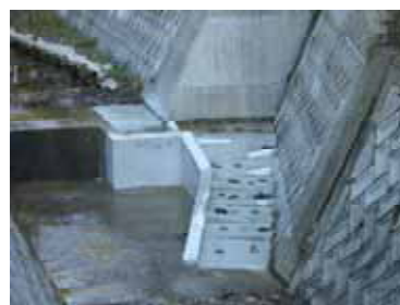
魚道の設置 (黒潮フルーツライン区域：和歌山県)
