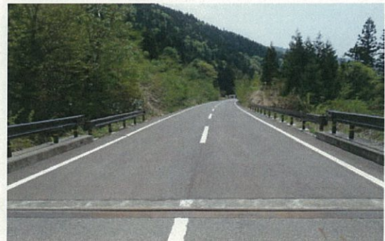
【景観の保全】茶色に塗装したガードレールの施工状況 (飯豊・檜枝岐線 一の木区間)
