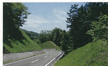
(八幡・高山線 馬瀬・萩原区間)
