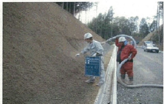
法面の緑化 (美濃東部区域:岐阜県)
