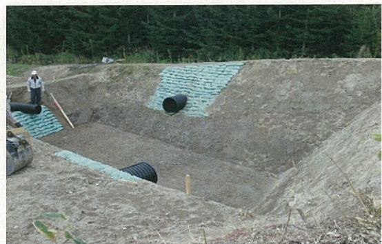
沈砂池の設置 (南富良野区域:北海道)
