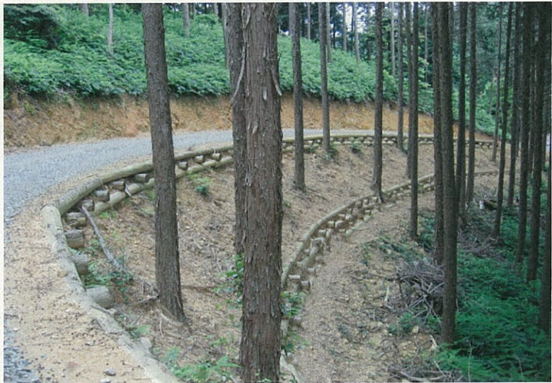
(丸太組工法による作業道)
