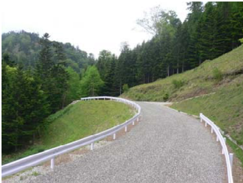
【法面の緑化】 木本類を導入した法面緑化 (平取・えりも線 様似・えりも区間)
