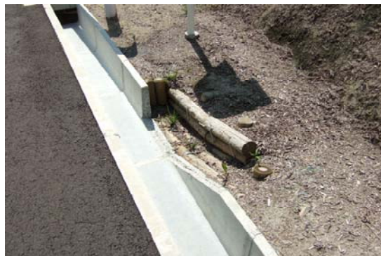
スロープ付側溝の設置 (美濃東部区域：岐阜県)
