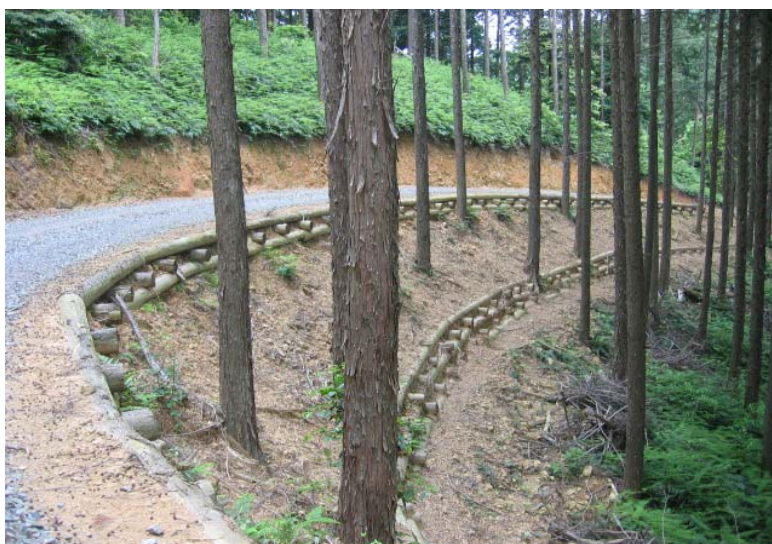
丸太組工法による作業道(熊本県球磨郡相良村)
