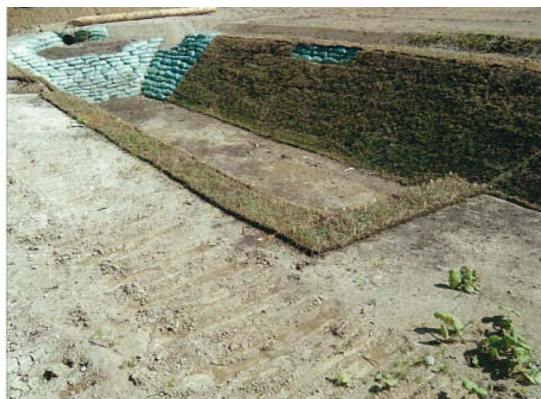
沈砂池の設置状況 (南富良野区域：北海道)
