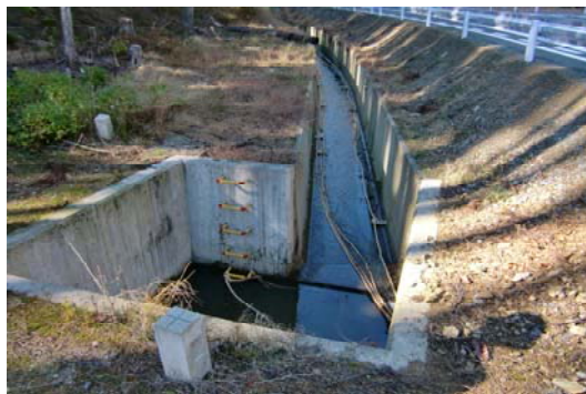
移動施設（ロープ）の設置 （美濃東部区域：岐阜県）
