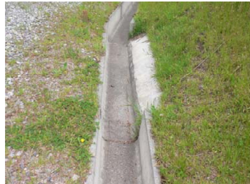
【小動物脱出路の確保】 スロープ付き側溝 (滝雄・厚和線 白滝・丸瀬布区間)
