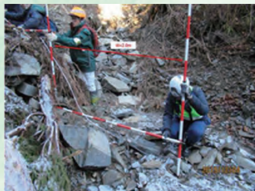
災害査定関連業務の作業状況（宮城県本吉郡南三陸町）
