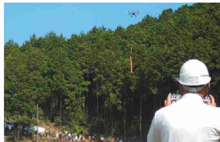
ドローンによる防護柵資材運搬
