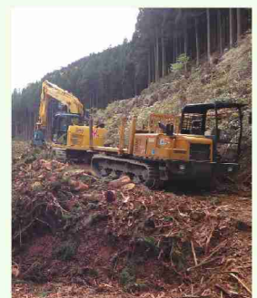
作業道を活用した搬出作業
