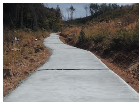
コンクリート舗装による作業道の補修
