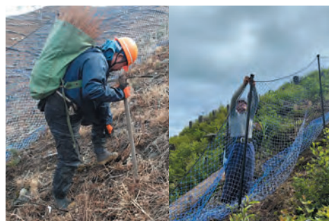
植栽及びシカ害防護柵の設置作業
