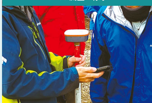
GNSS 測量の様子
