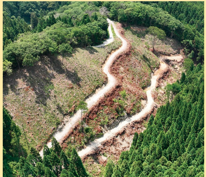
岡山県新見市の現場
