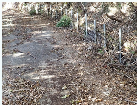
図2：木柵による土留工
