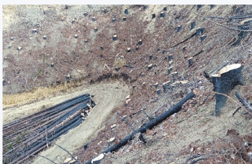
写真5: 林野火災の復旧(岩手県大船渡市)
