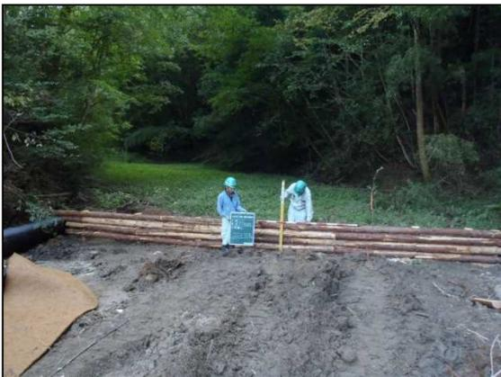
土砂流出防止柵施工状況
