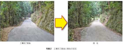
写真2 工事完了直後と現在の状況 写真1 工事完了直後
