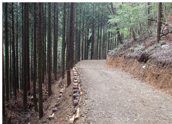
丸太組工法(のり留工)の設置例 (熊本県球磨郡五木村)
