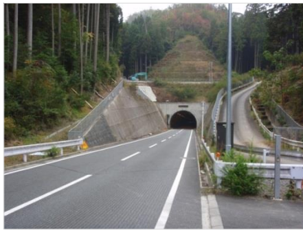
農業用道路 園部八木線1工区
