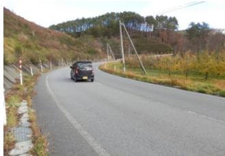
農業用道路(岩泉工区)
