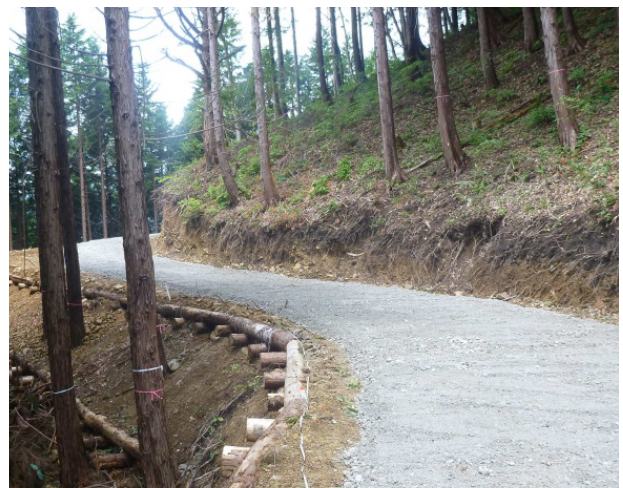
丸太組工法(のり留工)の設置例 (岡山県新見市)
