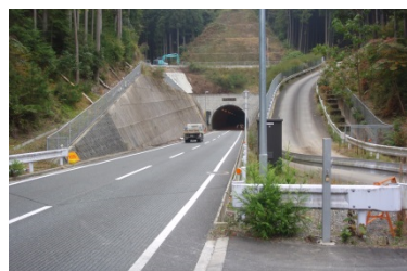
農業用道路(園部八木線1工区)
