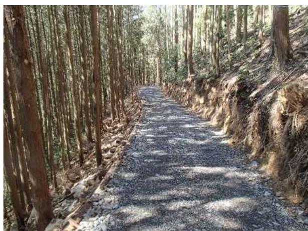
丸太組工法(のり留工)の設置例
