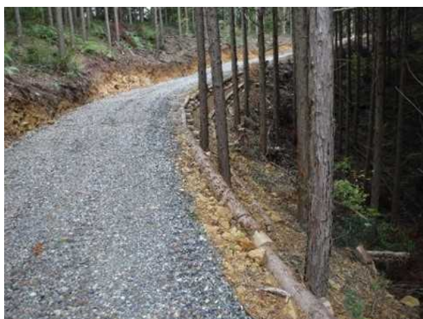
丸太組工法(のり留工)の設置例 (山口県萩市)
