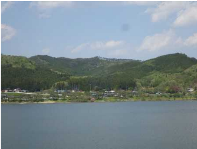
花山ダムと水源林造成事業地 (宮城県栗原市)
