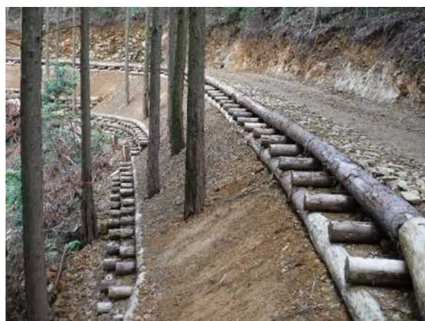
丸太組工法(のり留工)の設置例 (福岡県筑上郡筑上町)
