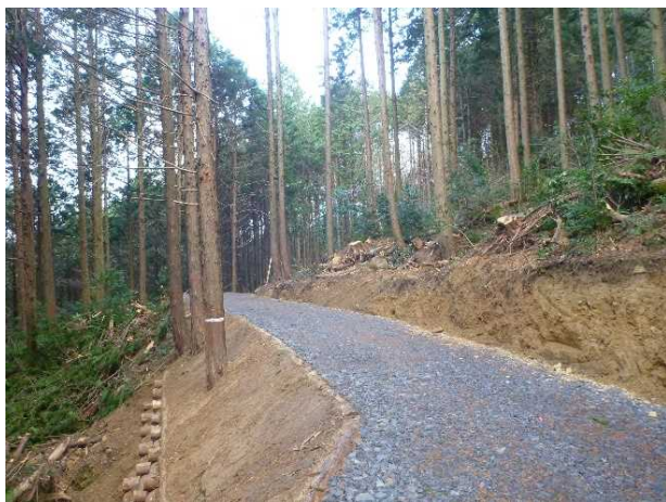
丸太組工法(のり留工)の設置例 (佐賀県唐津市)
