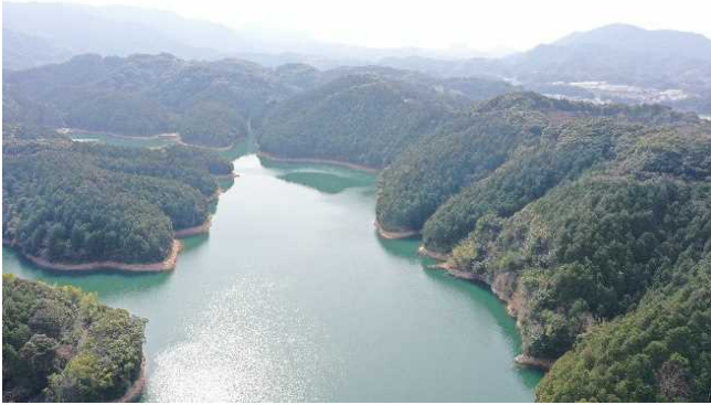
下の原ダム周辺の水源林造成事業地 (長崎県佐世保市)
