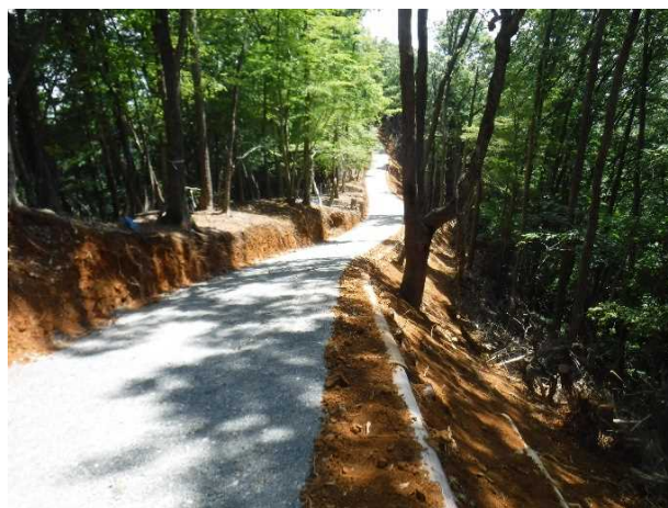
丸太組工法(のり留工)の設置例 (京都府綾部市)
