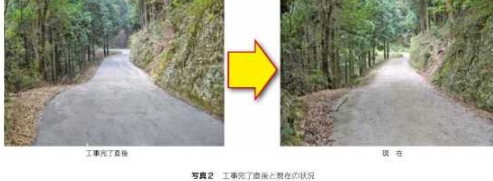
写真2 工事完了直後と現在の状況 現在
