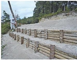
写真3 竹製土留工完成
