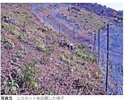
写真5 シムネットを設置した様子 (毎日の広域に分割して用を設け)
