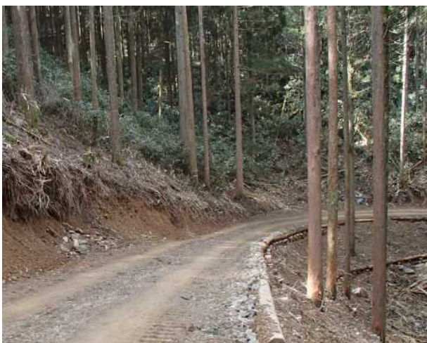
丸太組工法(のり留工)の設置例 (熊本県球磨郡五木村)
