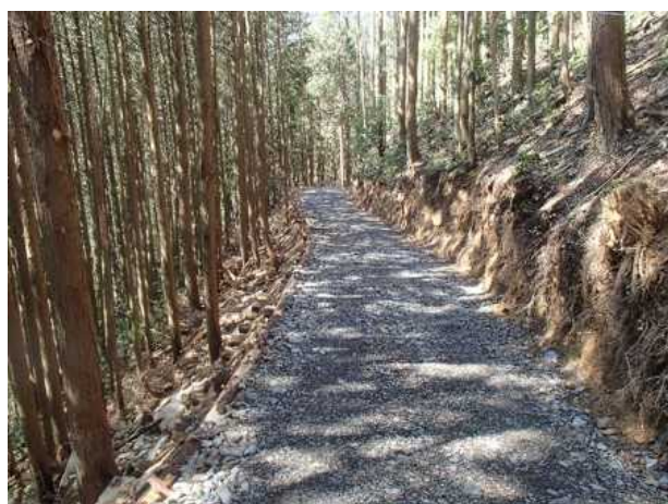
丸太組工法(のり留工)の設置例 (熊本県球磨郡多良木町)
