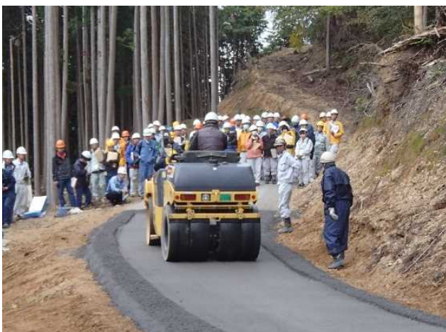
鉄鋼スラグを用いた路面処理についての現地検討 (中部整備局)
