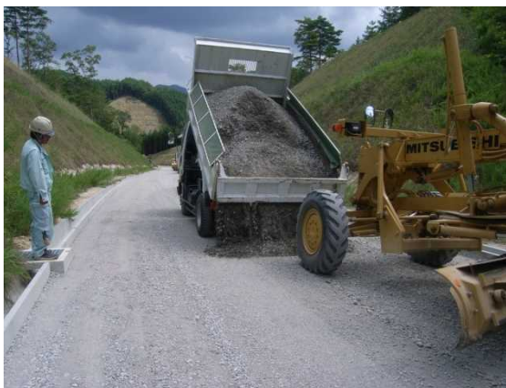
再生砕石敷均し状況【RC-40】 (邑智西部区域)
