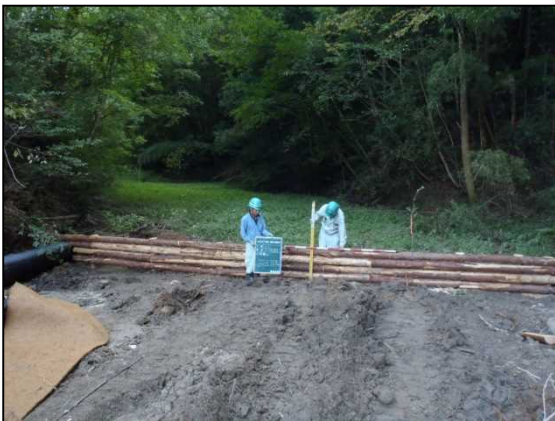
土砂流出防止柵施工状況 (邑智西部区域)
