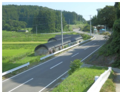
農業用道路3工区
