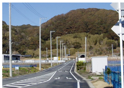
農業用道路3工区
