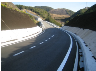
農業用道路2工区
