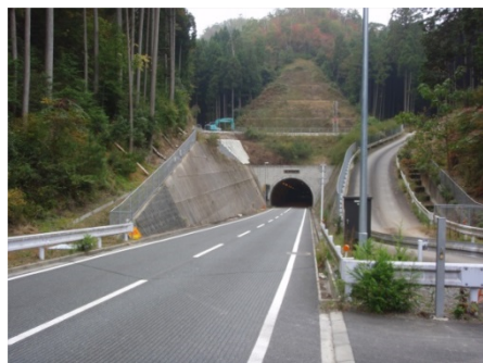
農業用道路 園部八木線1工区
