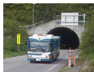
災害時に国道の代替路として機能(岩泉工区)
