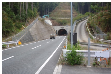
農業用道路(園部八木線1工区)
