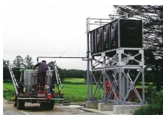
防除機への給水
