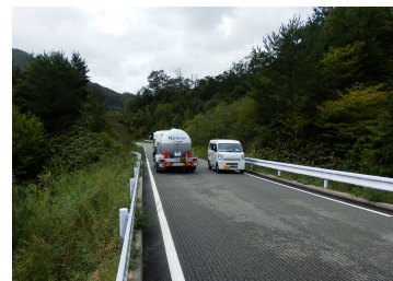
農林業用道路(3工区)
