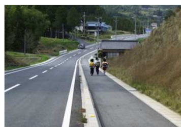
農業用道路(2工区)
