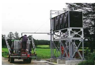
農業用用水施設(給水栓)
