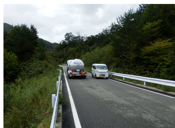
農林業用道路(3工区)
