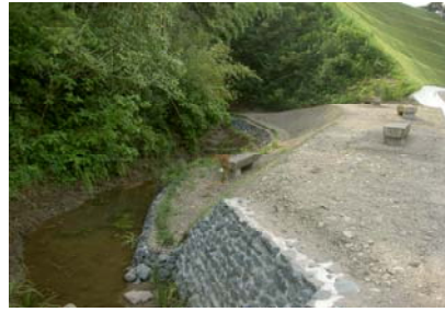
写真11. 工事暫定完了
