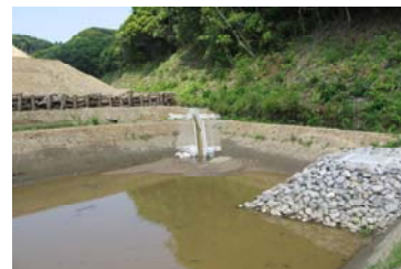
写真9. 沈砂池
