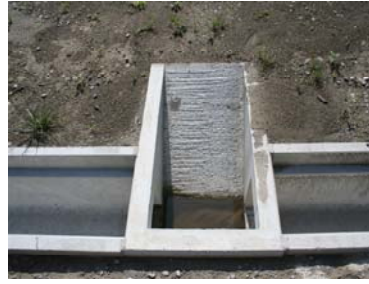
写真2. 側溝這い上がり柵
