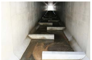
写真7. ボックスカルバート内部
