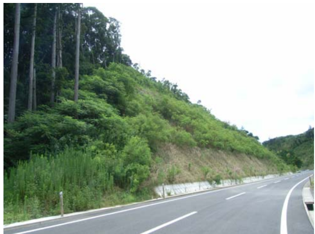
写真 - 2 全景 (施工後2年半経過)
