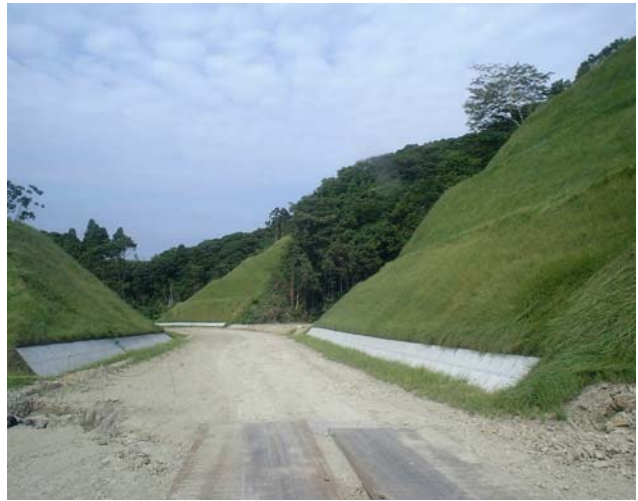
写真 - 1 全景 (施工後3ヶ月経過)
