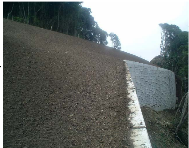
写真-4 施工直後（法面勾配 1:1.5~1:1.8）
