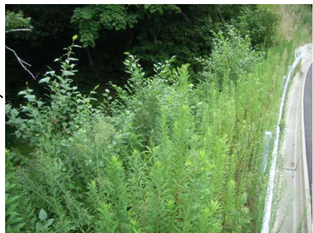
写真-6 施工後3年
