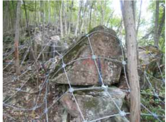
写真-4 ロープ伏工施工後状況
