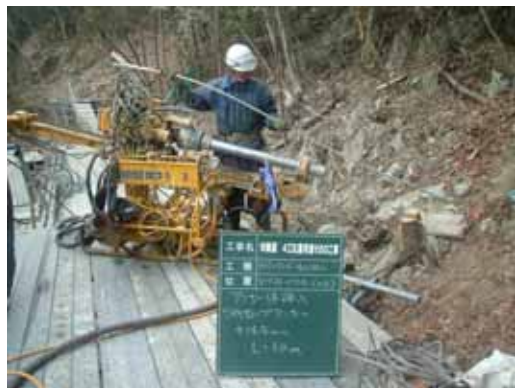
写真-11 アッ°-スロ-°-アソカ-の設置状況
