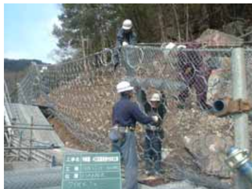
写真-13 リング°-ネット設置状況
