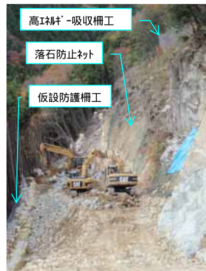
写真-15 地山の転石対策後の 農業用道路工事状況
