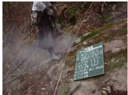
写真-5 岩部アンカー削孔状況
