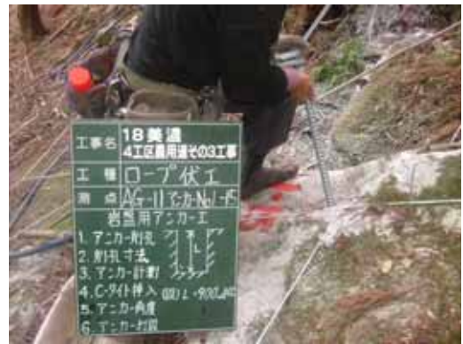
写真-6 岩部アンカー挿入状況
