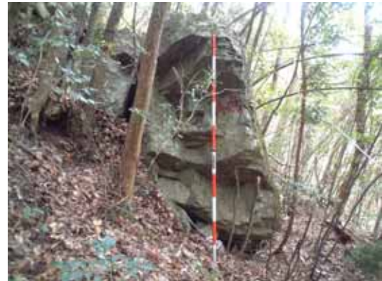
写真-2 不安定転石
