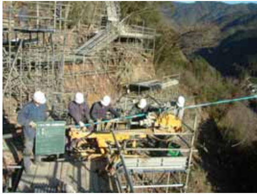
写真-10 ロ-列-パ°-カッションによる削孔後の 支柱基礎へ°-アソカ-挿入状況
