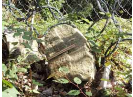
写真-14 施工済の高メッシュ°-吸収柵で捕らえた 20×30×20cm 程度の転石
