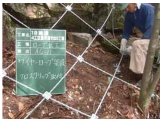
写真-7 ワイヤーロープ等設置状況
