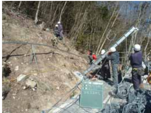
写真-12 支柱設置状況
