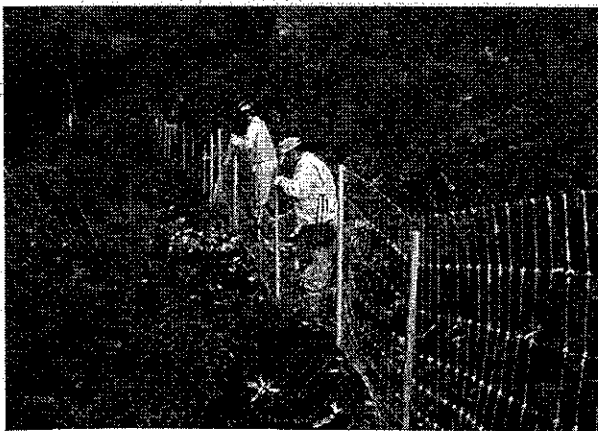
写真-2 住民直営施工による防護柵設置作業の状況
