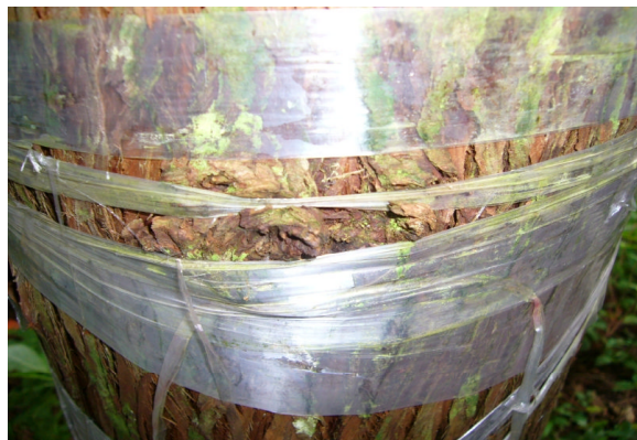
写真-8 テープの食い込み状況
