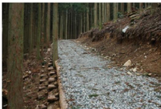
図 2 従来の積上工による施工例
