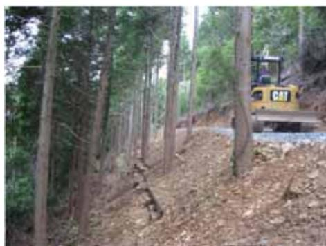
図 3 のり留工による施工
