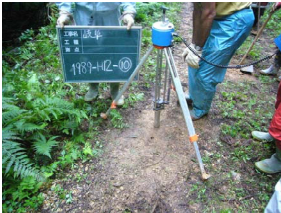
簡易支持力測定器(キャスポル)による調査状況
