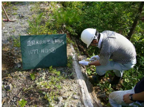
木材測定器(ピロディン)による腐朽度測定
