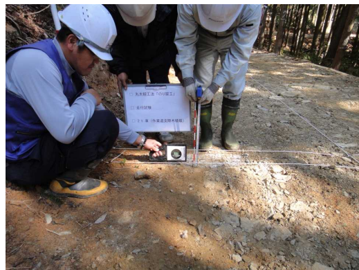
写真－１４ 沈下量の計測状況
