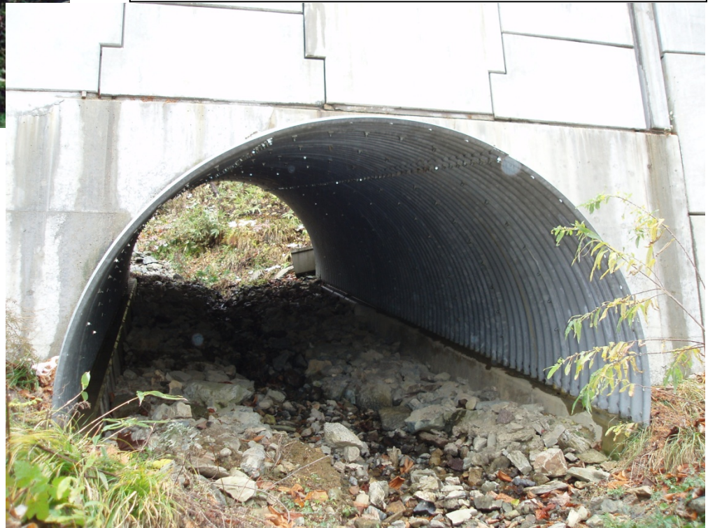
半円形コルゲートパイプ施工後の溪床
