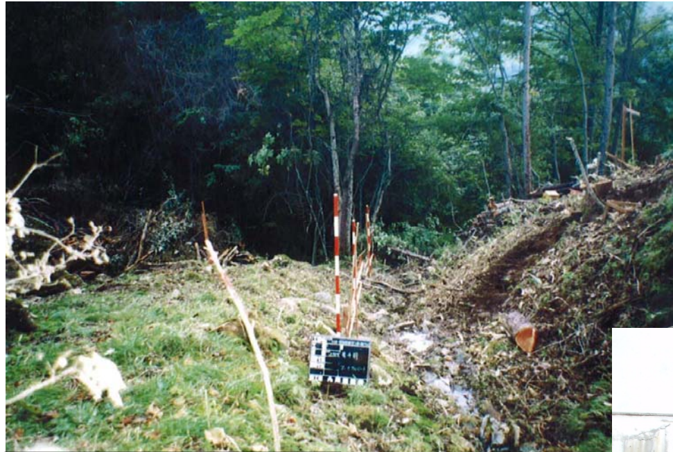
施工前の自然溪床
