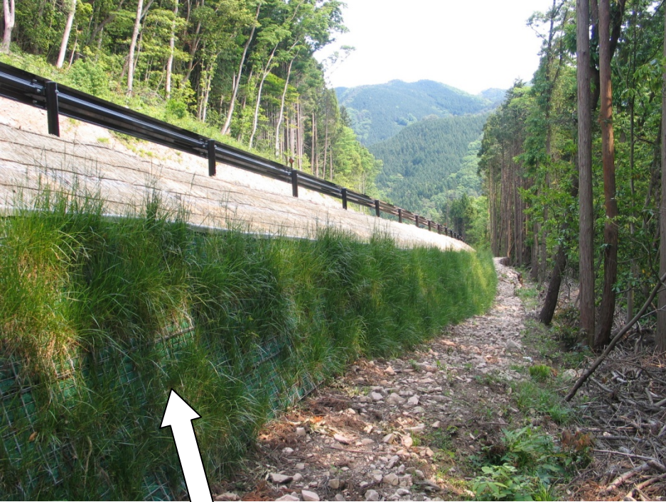
補強土壁工・むしろ張工
