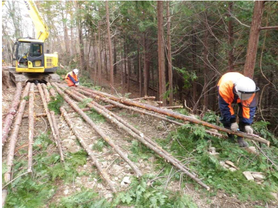
写真15 9m材の規格を確認
