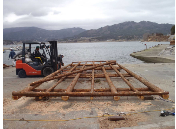
写真8 木材部分の組立が完成したカキ筏
