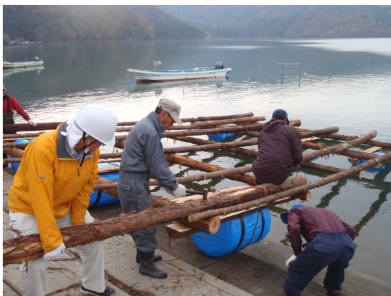
写真17 カキ筏の組立作業
