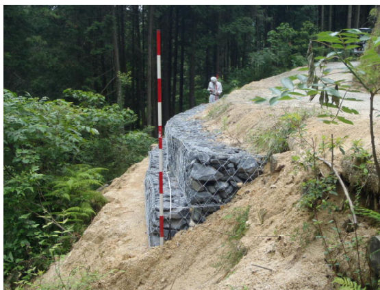
写真-4：フトン籠工設置状況
