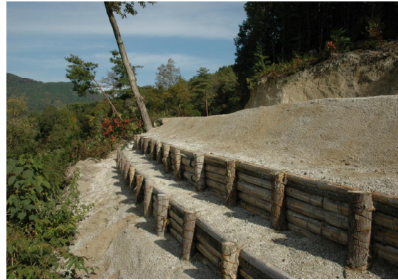
写真-15：施工後4ヶ月経過状況
