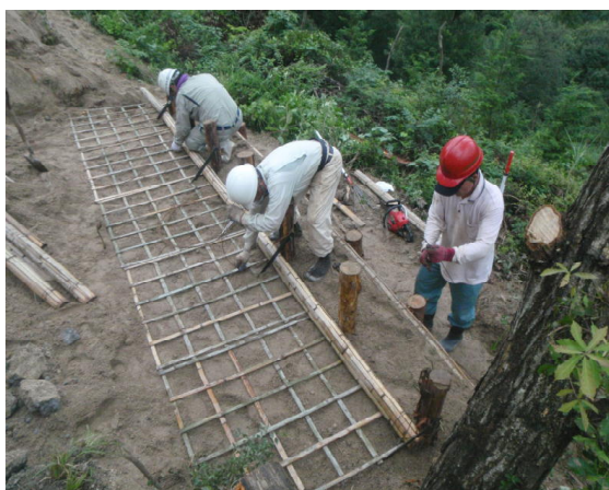
写真-12：上段柵竹ソダ設置状況 写真-13：上段柵竹マット2段目敷設状況
