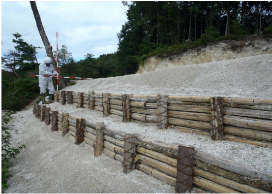
写真-14：全体完成状況
