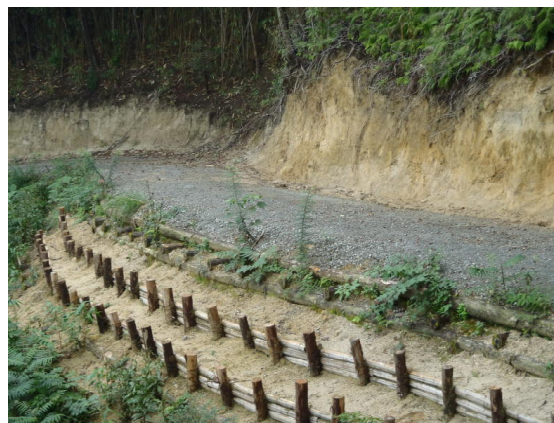
写真-5：柵工設置状況(竹ソダ柵杭打式)
