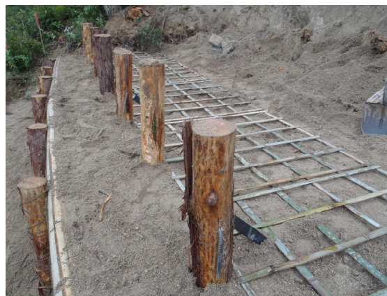
写真-10：下段柵竹マット2段目敷設状況 写真-11：下段柵完成・上段柵竹マット1段目敷設状況
