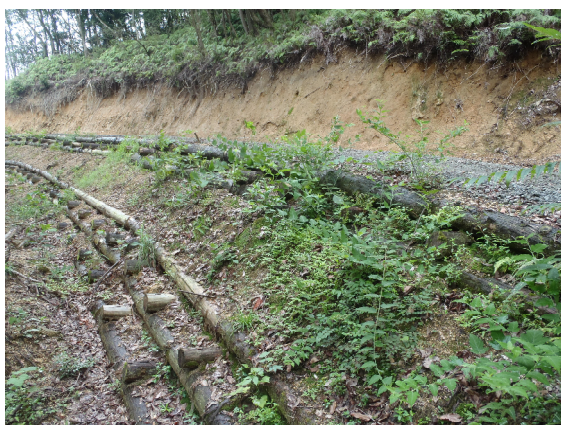
写真-3：丸太組工法面植生回復状況
