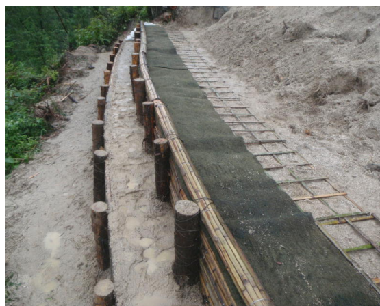
写真-12：上段柵竹ソダ設置状況 写真-13：上段柵竹マット2段目敷設状況
