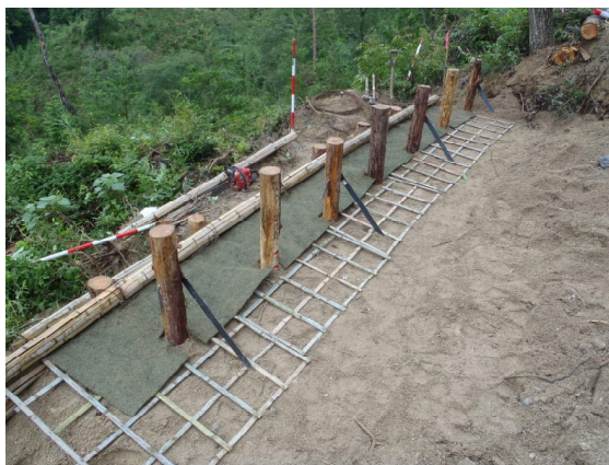
写真-10：下段柵竹マット2段目敷設状況 写真-11：下段柵完成・上段柵竹マット1段目敷設状況
