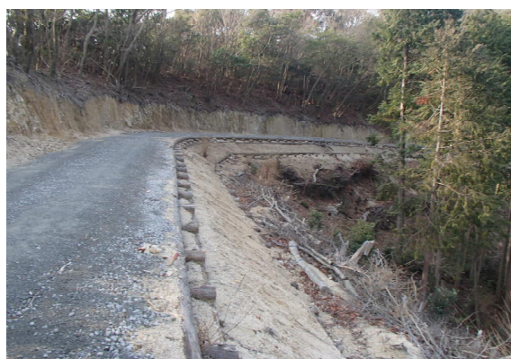
写真-2：マサ土地域丸太組工施工直後状況
