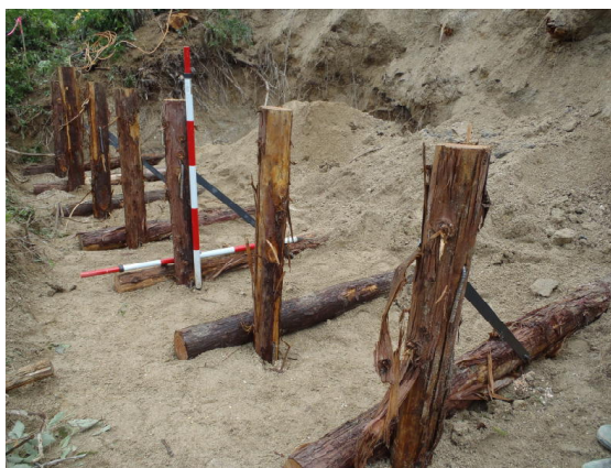
写真-6：杭木・横木設置状況
