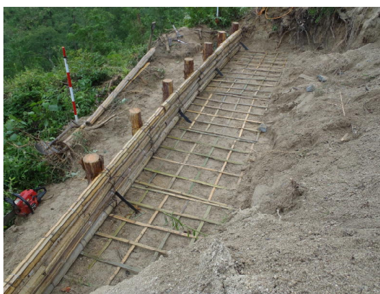
写真-8：竹ソダ設置状況
