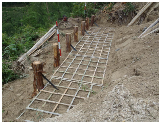
写真-7：下段柵竹マット1段目敷設状況
