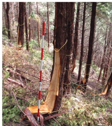
写真-3 ロープ施工後被害
