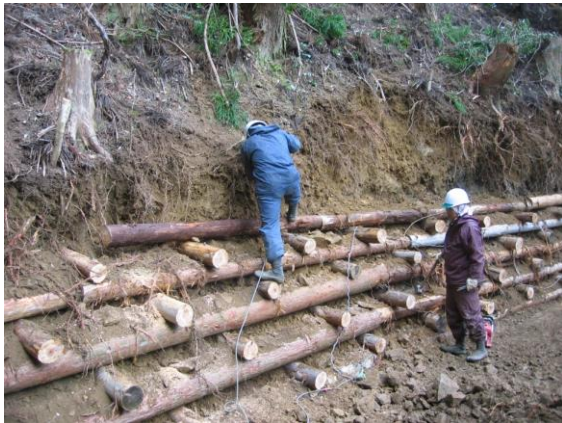
写真-6：山側丸太組工法の施工状況
