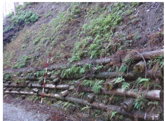
写真-9：植生マットの設置状況-2
