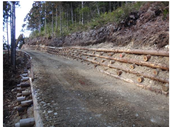
写真－14：路盤材に現地発生材を利用した状況
