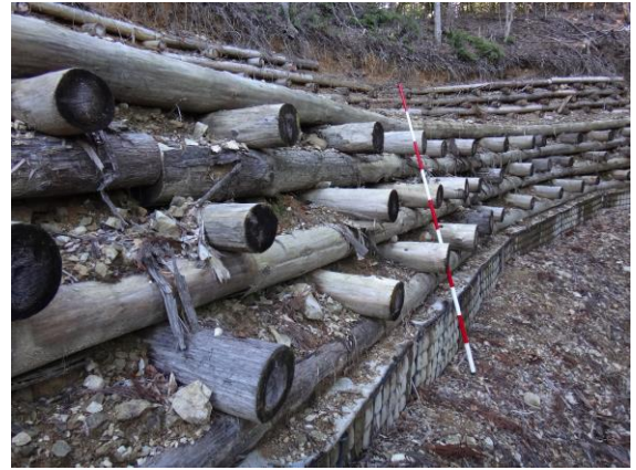
写真-5：積上工及びかご枠の完成状況
