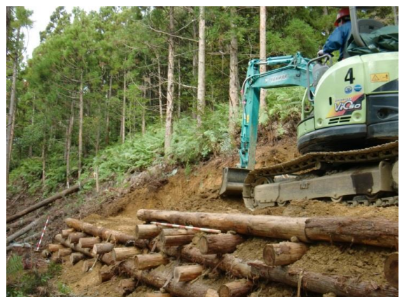
写真-4：積上工設置状況-2
