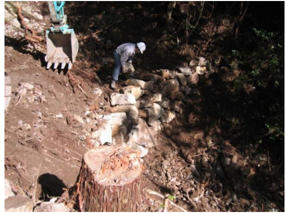
写真-10：石積工（沢部）の施工状況
