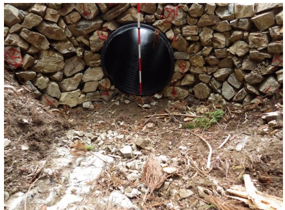
写真-12：石積工（吐口部）の完成状況
