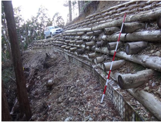
写真-5：積上工及びかご枠の完成状況
