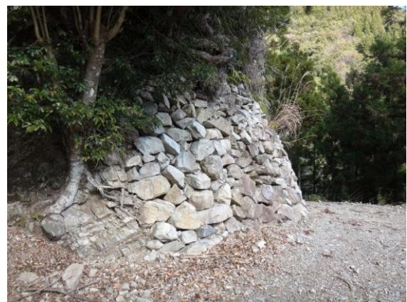
写真-13：石積工（切取法面部）
