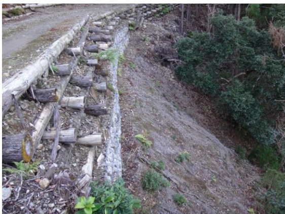
写真-8：植生マットの設置状況-1
