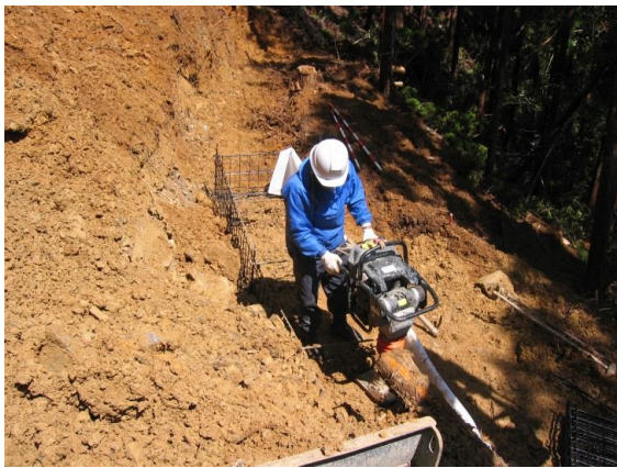
写真-1：かご枠設置状況-1
