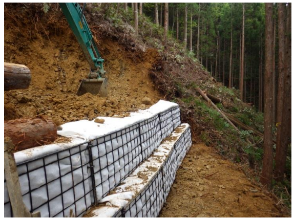
写真-2：かご枠設置状況-2
