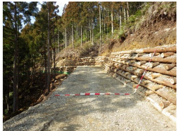
写真-7：山側丸太組工法の完成状況
