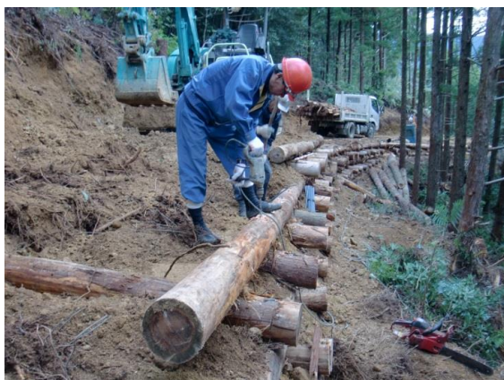
写真-3：積上工設置状況-1
