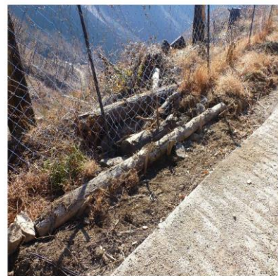
丸太による応急処置
