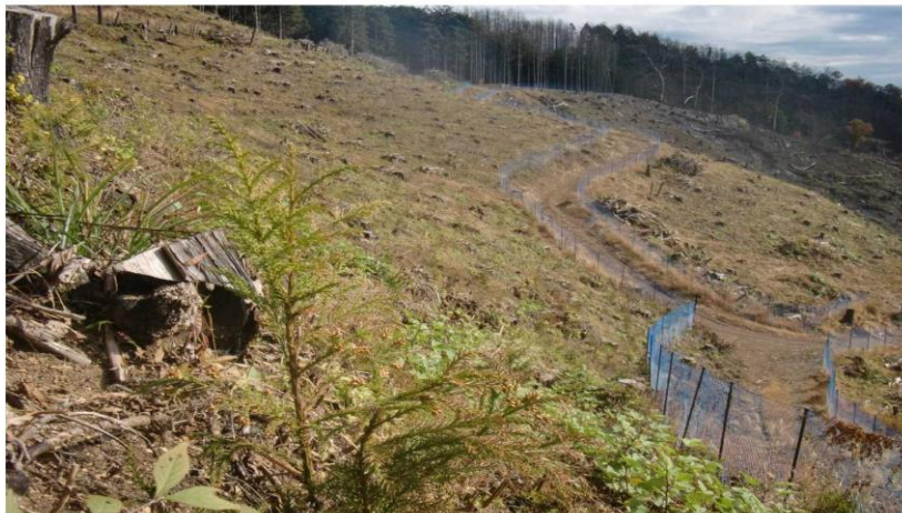
(写真-1 防護柵設置状況)
