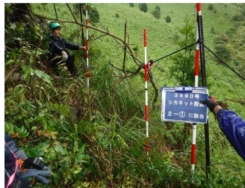
（倒木が原因による破損）
