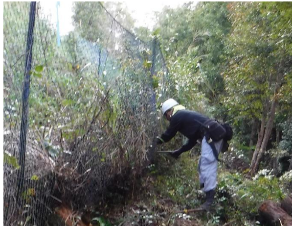
写真－6 遮光ネット設置前の刈り払い
