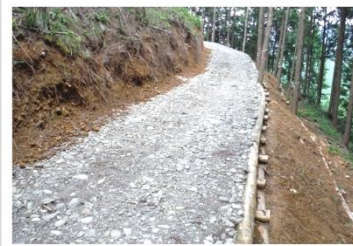
山ずりで施工した作業道
