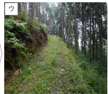
R2年現在：施工5年後
