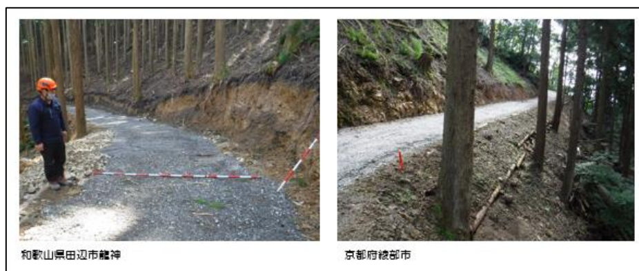
写真3 敷砂利工（従前から取り組んできた工法2）
