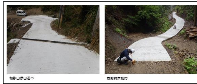
写真4 コンクリート工（従前から取り組んできた工法3）
