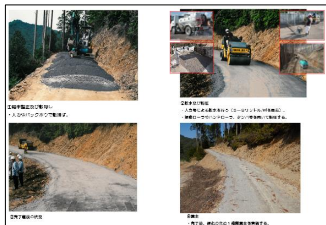
写真6 鉄鋼スラグ工（近年取り組みはじめた工法2）
