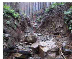
図2 洗堀被害の状況
