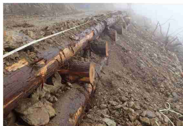
図5 路面補強工の実施
