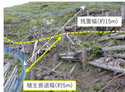
図 14 カメラ A 付近の状況
